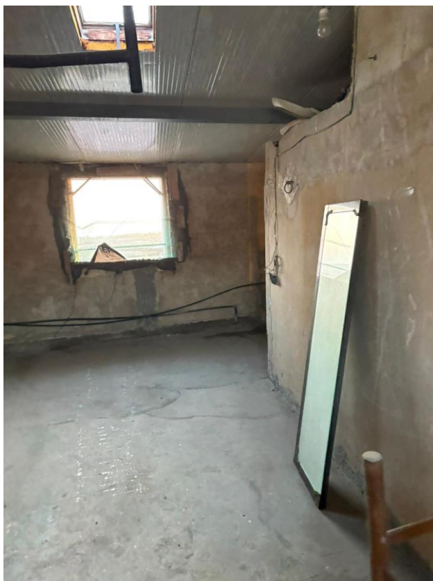
20. Piano Terzo – Unico ambiente non rifinito e coperto con pannelli coibentati
