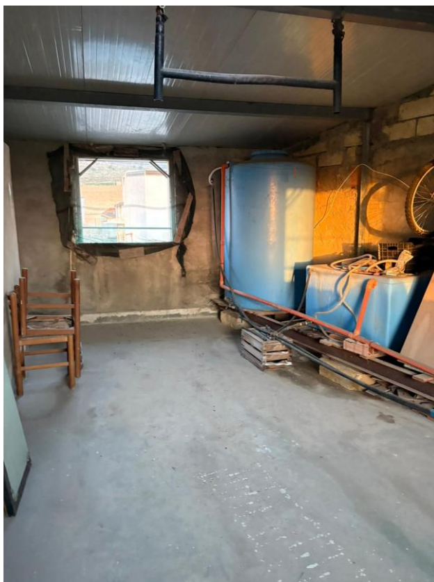
19. Piano Terzo – Unico ambiente non rifinito e coperto con pannelli coibentati
