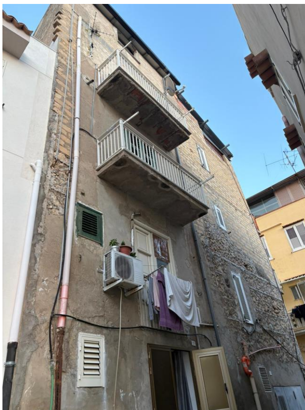
2. Prospetto esterno – lato sud-ovest via dei Pastori
