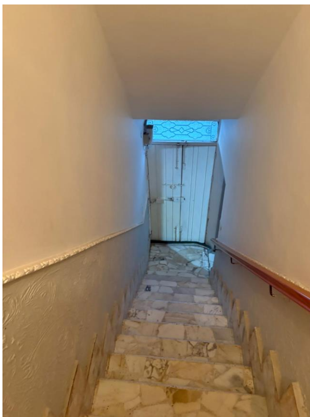
10. Vano scala – portone di ingresso via S. Antonino
