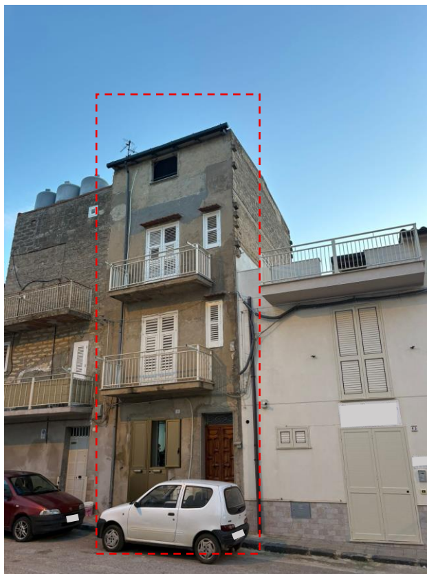
1. Prospetto esterno – lato nord-est via Sant'Antonino
